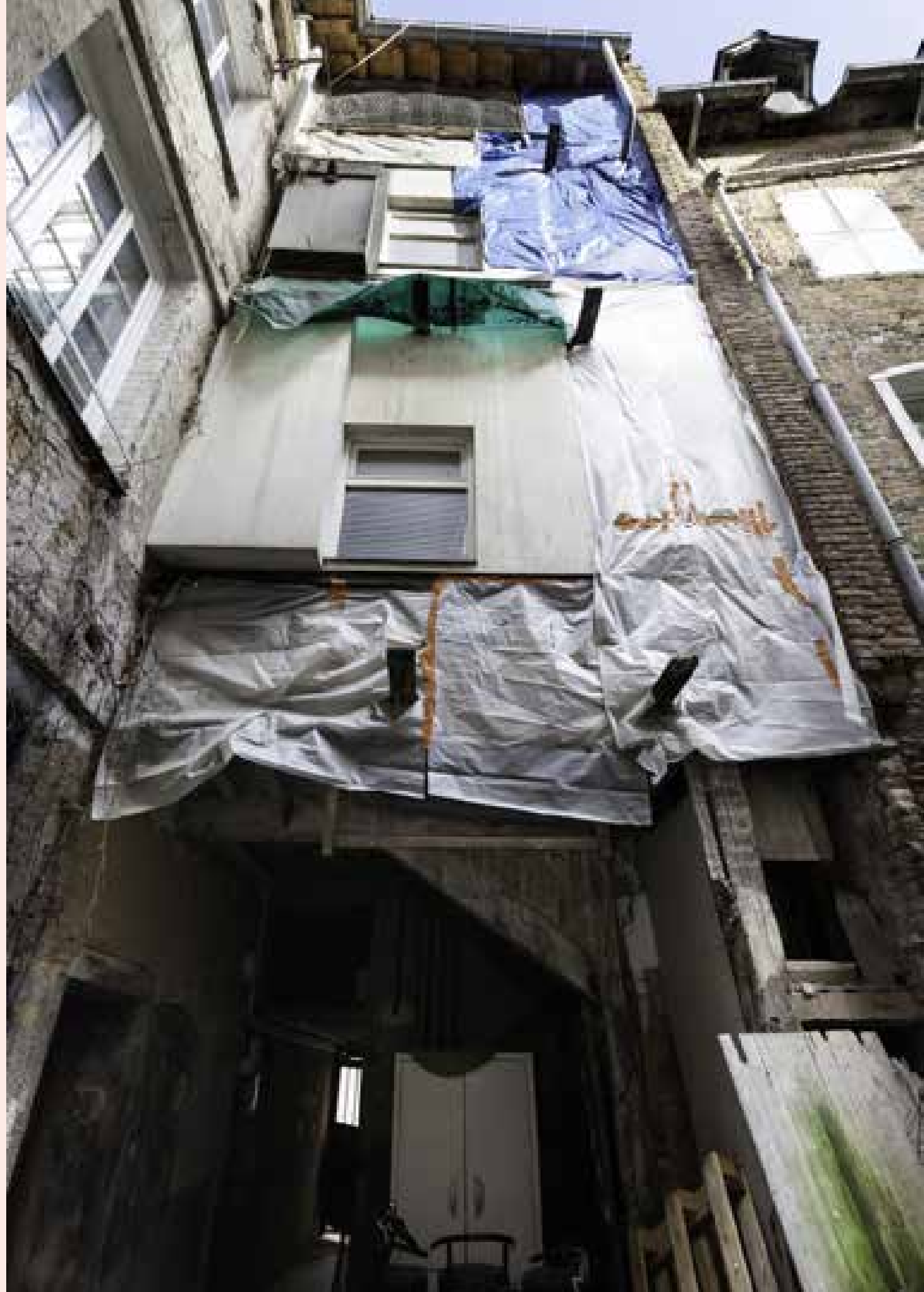
3, rue de Clisson avant travaux
