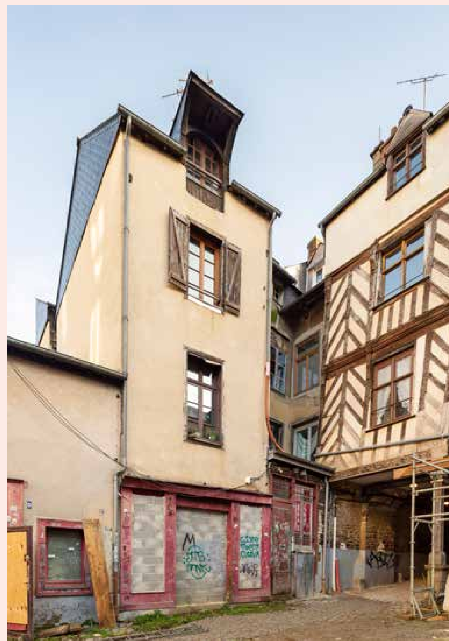
15, rue Saint-Michel avant travaux
