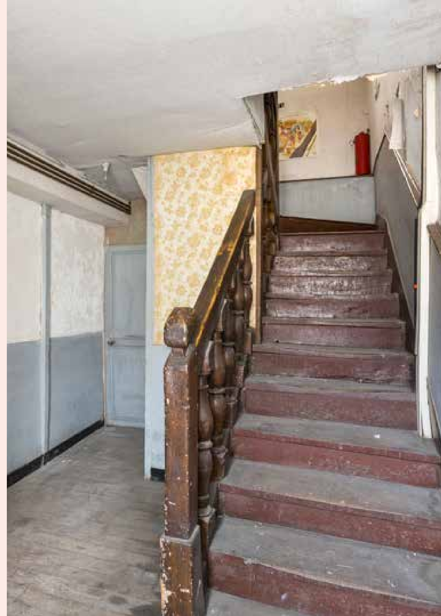
5, rue de Corbin avant travaux
