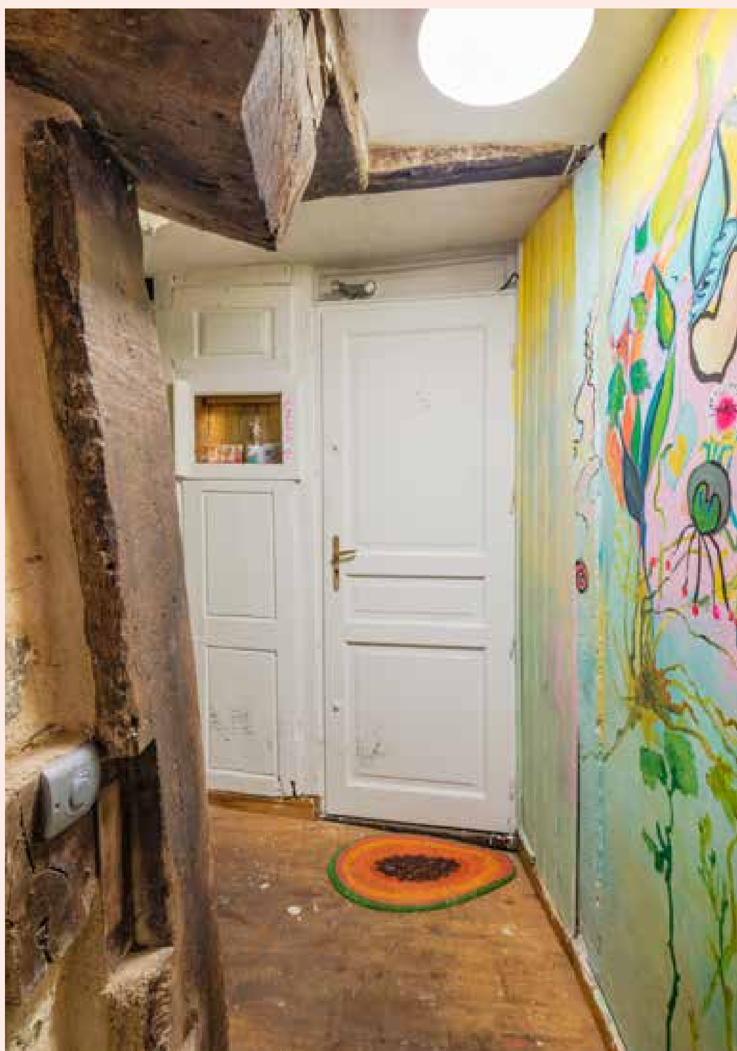
8, place Saint-Anne avant travaux
